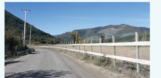
設置したフェンス
